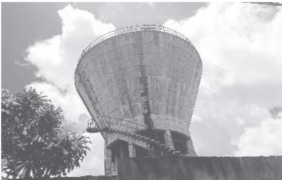
Caixa D'Água – Ilha Amarela
