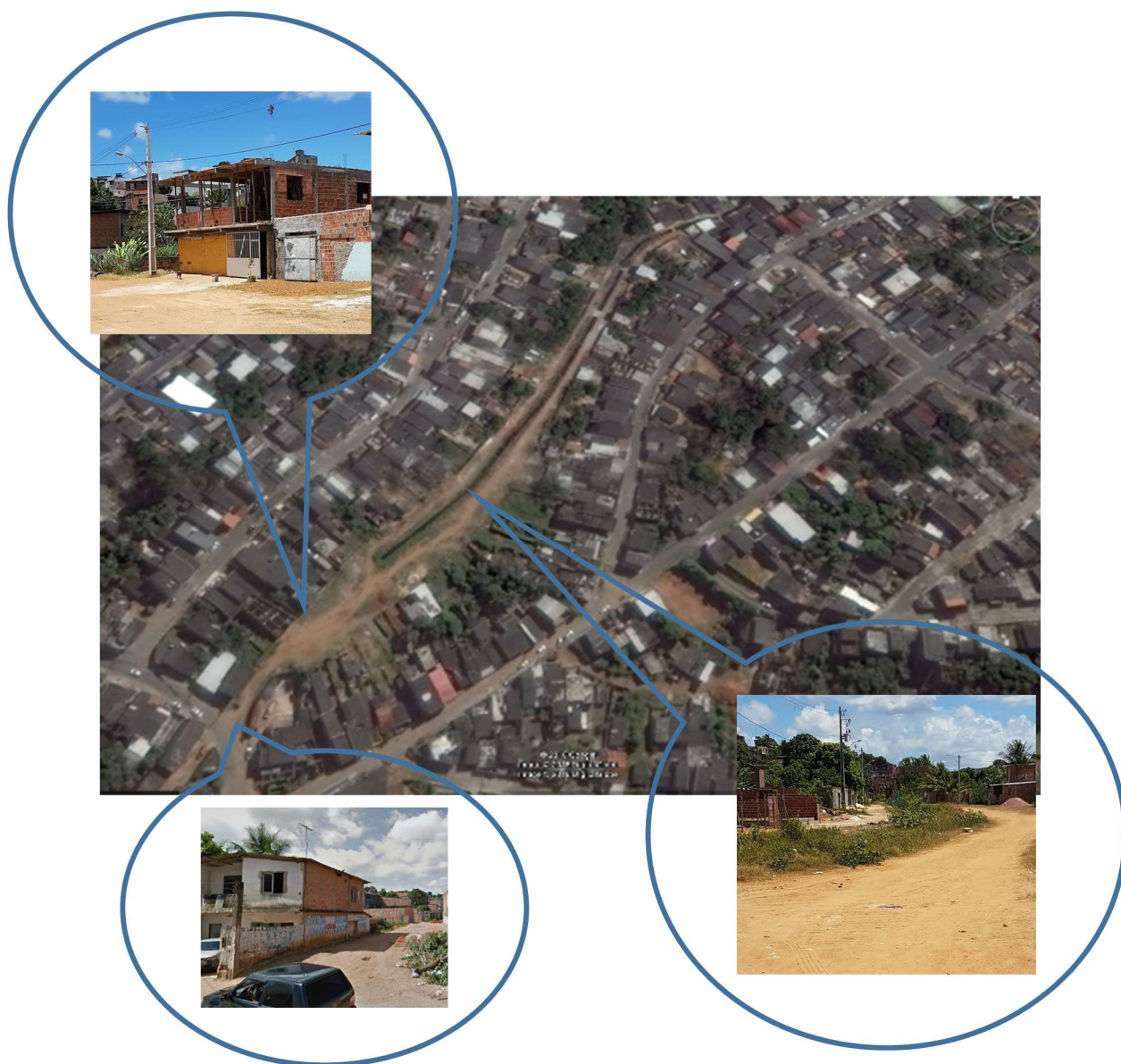
Figura 34 – Vista do Rio Mane Dendê – Trecho com drenagem executada recentemente
